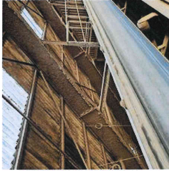
Annexe: Photos – visite d’inspection du 17/10/2025 FORT EMPOUSSIÈREMENT DANS LE SILO 1 DU SITE AXEREAUX A VALD’YERRE
