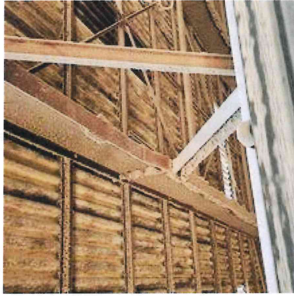
Annexe: Photos – visite d’inspection du 17/10/2025 FORT EMPOUSSIÈREMENT DANS LE SILO 1 DU SITE AXEREAUX A VALD’YERRE
